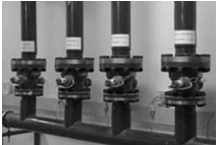
Рис. 2.21 – Розподільчі пристрої АСГП з діаметрами умовного отвору 80 мм
