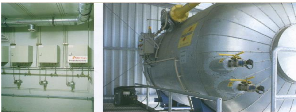
Рис. 2.5.1.4. Централізоване зберігання ВГР в ізотермічній ємності
