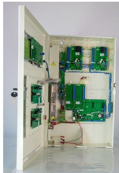
Розташування блоків в приладі «Варта»
