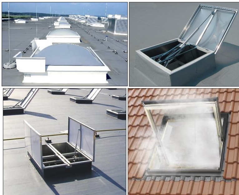
Рис. 4.3.5. Видалення диму через ліхтарі та віконні фрамуги
