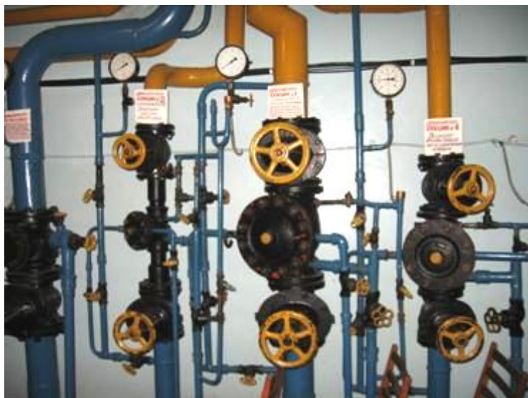
Рис. 2.66 – Вузол управління установкою автоматичного пожежогасіння палацу культури
