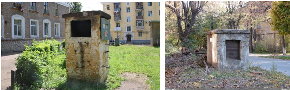
Рис. 14. Оголовок аварійного виходу з захисної споруди.
